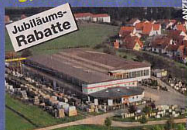
Moderne Produktions- und Lagerhallen
